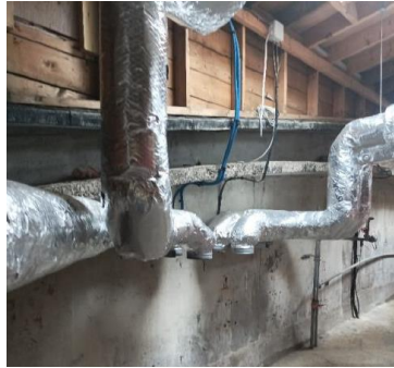
Anciens réseaux de ventilation double flux
