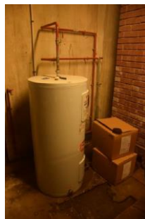
Production d'ECS par ballon électrique en chaufferie
