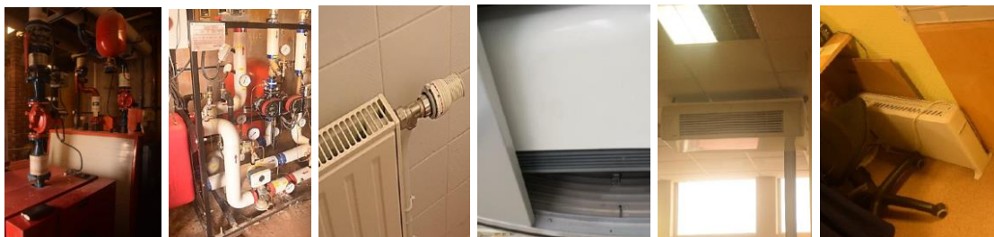
Chaudière fioul, skid RCU, radiateur, ventilo-convecteur, climatisation local boîte postale, radiateur d'appoint
